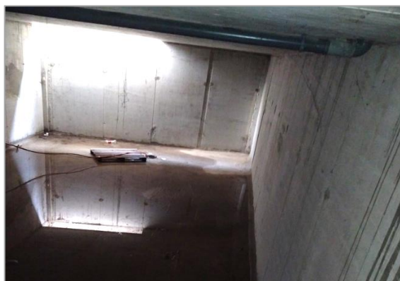
pogled prema svjetlarniku iz prizemlja (do ulice)
